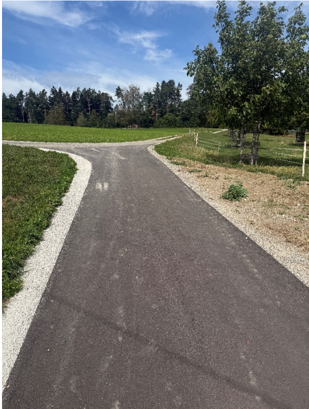
Bild 2: Berghaldenstrasse nach der Sanierung
