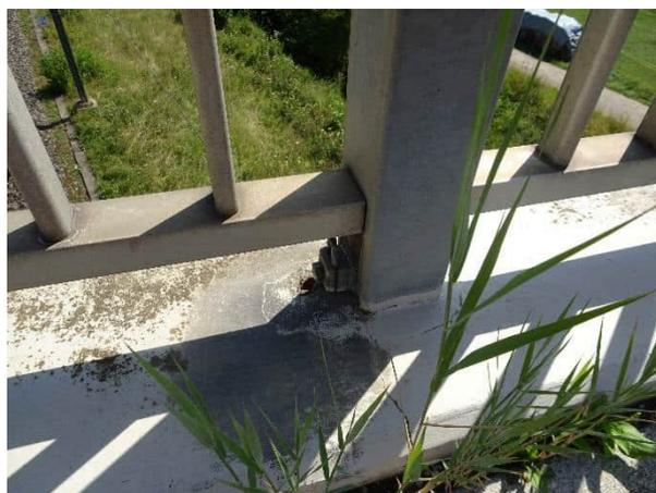
Abbildung 8 Erdungsanschluss an Bahnerde
