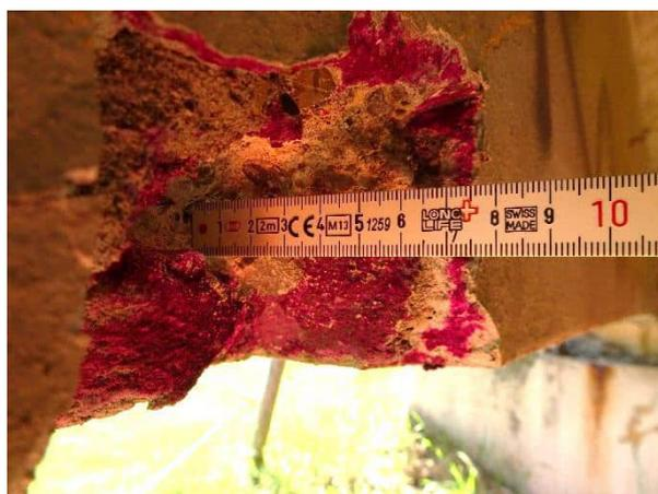
Abbildung 22 Karbonatisierter Beton hinter Reprofiliermörtel
